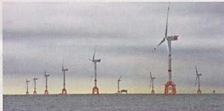
Nach Schätzungen des Bundesverbandes Windenergie machen Service und Wartung bis zu 25 Prozent der Kosten von Offshore-Windparks aus.
