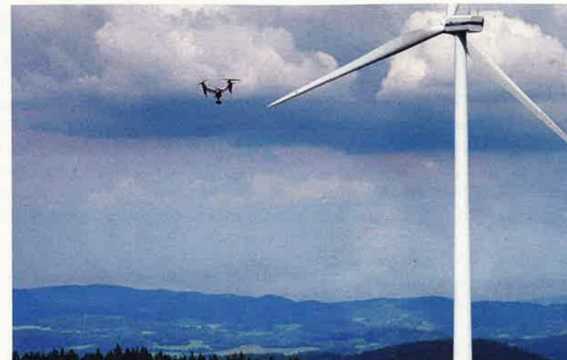
Die Inspektion mit den speziellen Flugrobotern kann bei Onshore- und Offshorewindkraftanlagen durchgeführt werden. Bilder: Aero Enterprise
