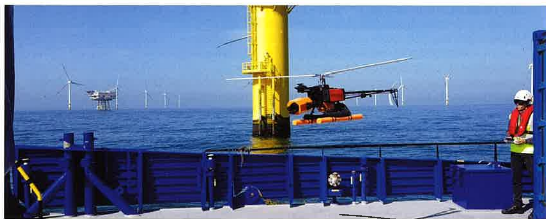
Der Aero-SensorCopter startet zu seinem Wartungsflug an einer Offshore-Anlage
